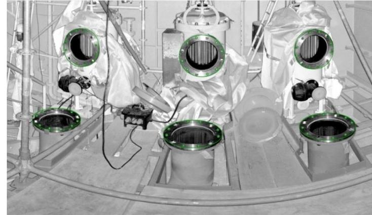
Zu verbindende Rohrsysteme mit identifizierten Anschlussgeometrien
