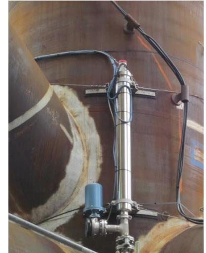
Kabelhalterungen (geschweißt) und Fremdstromanode an Jacket-Struktur
