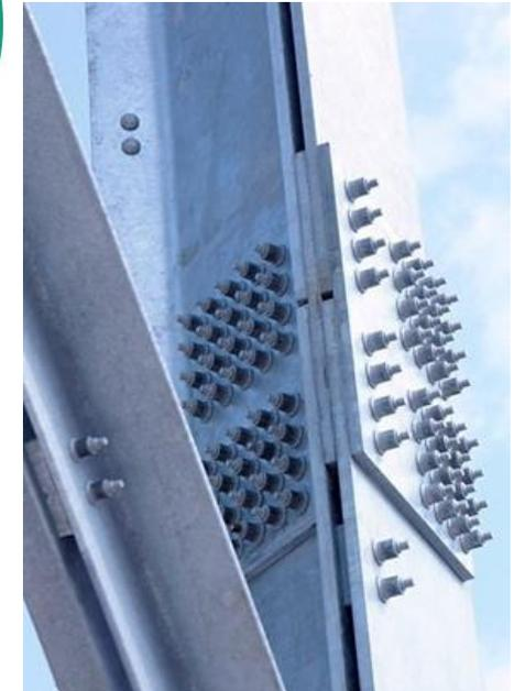
Gittermast mit Schließringbolzen (oben)
